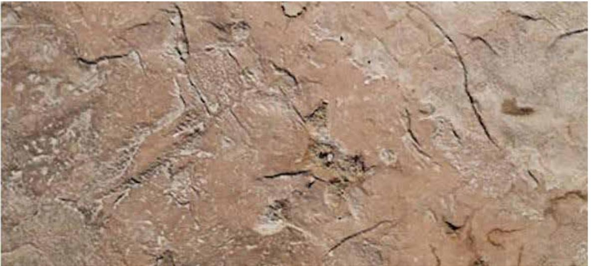
Le pavimentazioni stampate sono realizzate seminando la malta cementizia sull'estradosso del calcestruzzo e procedendo ad incorporo con frattazzi e lame metalliche a manico lungo.
