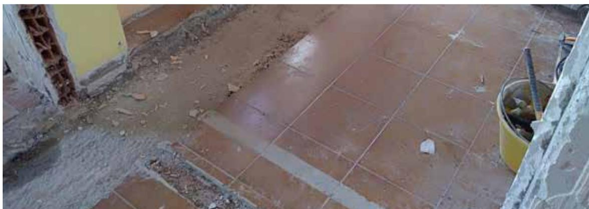
Per le caratteristiche intrinseche delle pavimentazioni flottanti posate a secco, questa soluzione può rappresentare un valido aiuto nella ristrutturazione interna di edifici.
