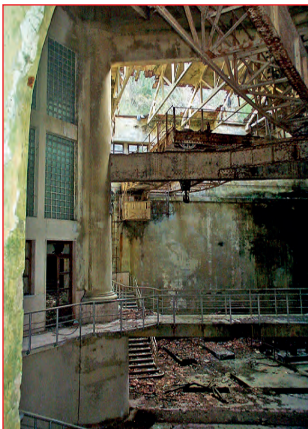
Lo stato attuale della grande colonna al centro della sala di comando (v. foto sopra).
