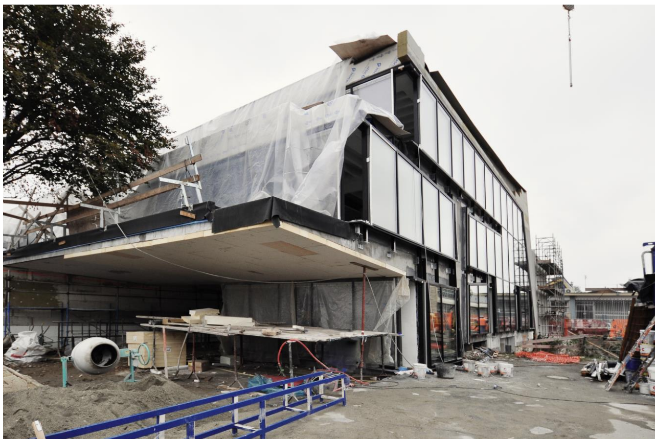
Figura 4 – L’involucro in fase di realizzazione: rivestimento a cappotto delle strutture opache e dettaglio della facciata continua nord-est.
