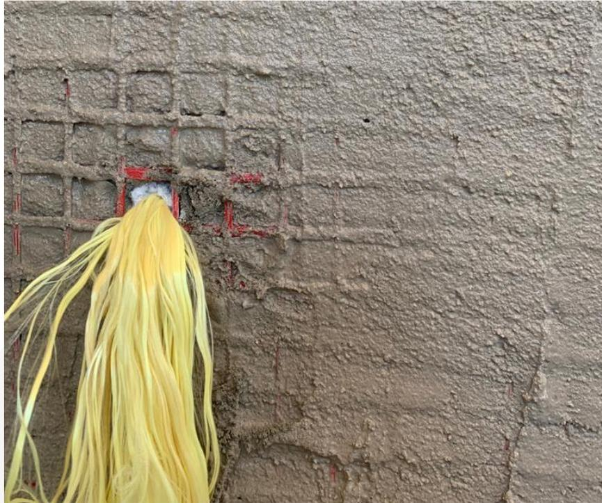
*Fiocco in aramide OLY ROPE ARAMIDE per il collegamento del sistema antiribaltamento al telaio in cls*
