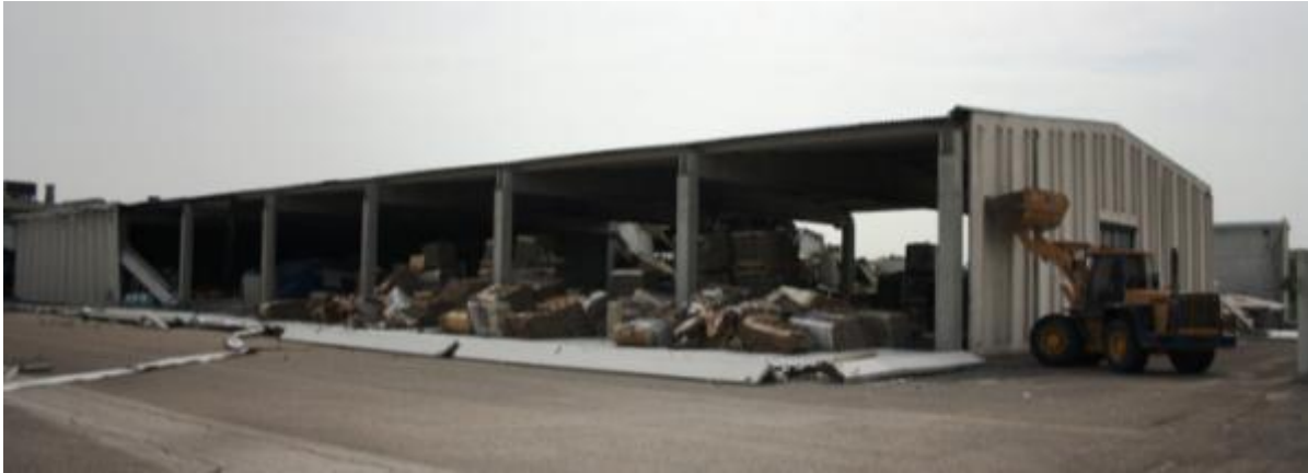
Figura 7. Caduta di pannelli prefabbricati verticali.
