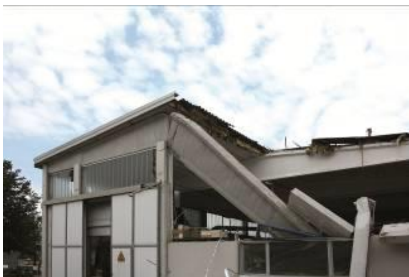
Figura 1. Caduta di travi per perdita dell'appoggio.
