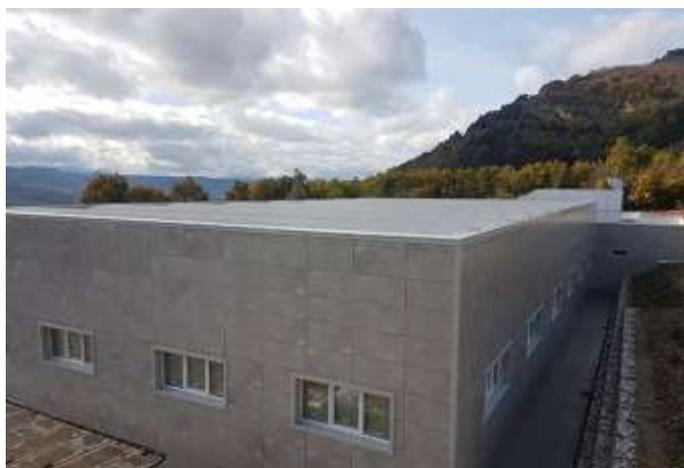
Questi obiettivi sono stati raggiunti mediante la realizzazione di una **facciata ventilata** che avvolge l'intero involucro dei nuovi edifici, per la quale è stato selezionato il sistema ISOTEC PARETE di Brianza Plastica con rivestimento in lastre di grès.
