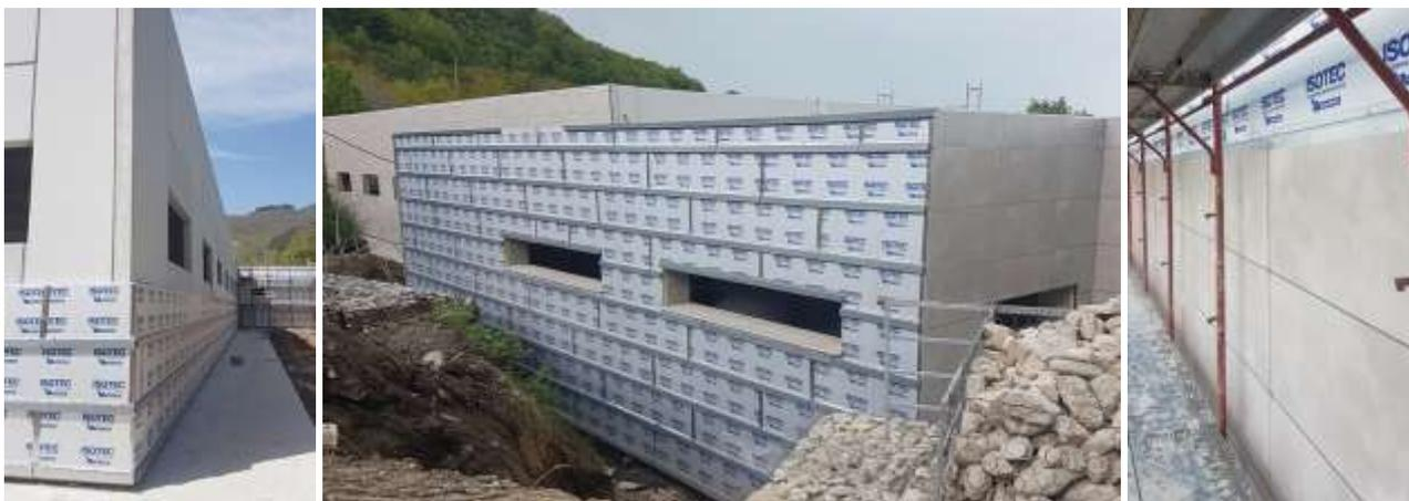
I pannelli Isotec Parete sono fissati meccanicamente al supporto mediante appositi tasselli, mentre il correntino metallico costituisce il supporto ideale per l'ancoraggio delle clip, che sostengono **le lastre in grès formato 120x60 cm**, scelte per la loro **estetica naturale effetto pietra**, che ben si integra con l'intorno.
