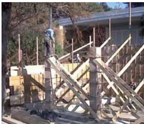
Figura 1. Situazioni ricorrenti nei cantieri a volte ai limiti delle più elementari regole della sicurezza per il lavoratore e la struttura: altezze di getto eccessive che determinano segregazione ai nodi o alle riprese di getto, gabbie metalliche che poggiano lungo le sponde della casseratura, pilastri privati del copriferro nominale per fare spazio ai pannelli termo-isolanti.
