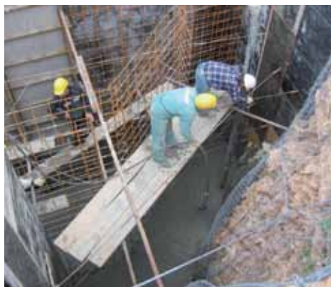
Figura 1. Situazioni ricorrenti nei cantieri a volte ai limiti delle più elementari regole della sicurezza per il lavoratore e la struttura: altezze di getto eccessive che determinano segregazione ai nodi o alle riprese di getto, gabbie metalliche che poggiano lungo le sponde della casseratura, pilastri privati del copriferro nominale per fare spazio ai pannelli termo-isolanti.
