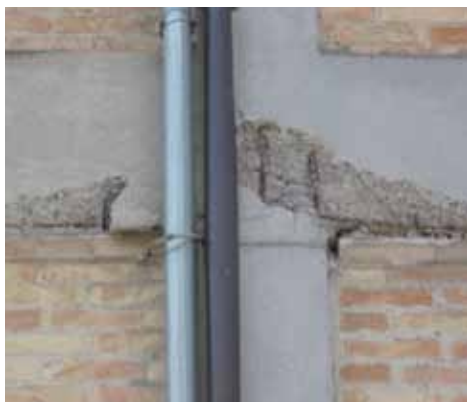
Figura 3. Pratiche "correttive" dei difetti esecutivi. Spesso i capitolati dedicano più attenzione alla scelta del prodotto da ripristino che alla corretta progettazione e specifica delle operazioni di posa in opera.
