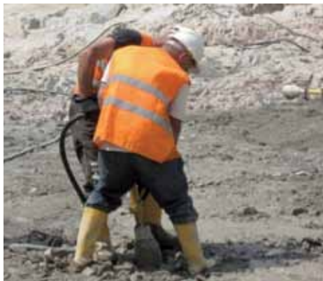
Figura 4. La vibrazione di un calcestruzzo massivo per opera idraulica: le procedure esecutive e di sicurezza richiedono un'attenta progettazione e specifica della metodologia operativa al fine di garantire qualità strutturale ed eliminare le interferenze tra le fasi lavorative.
