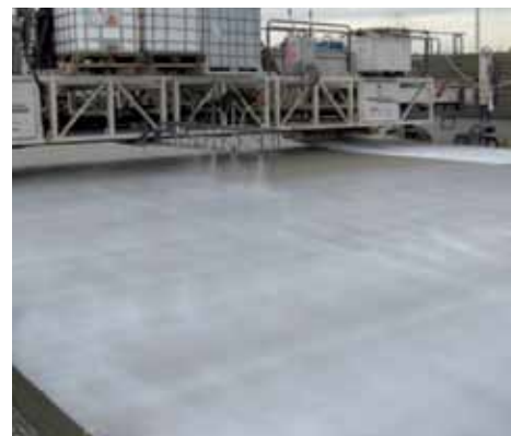
Figura 5. Alcuni esempi per una corretta procedura di maturazione delle strutture: irrorazione con acqua, utilizzo di agenti di curing, protezione con teli.
