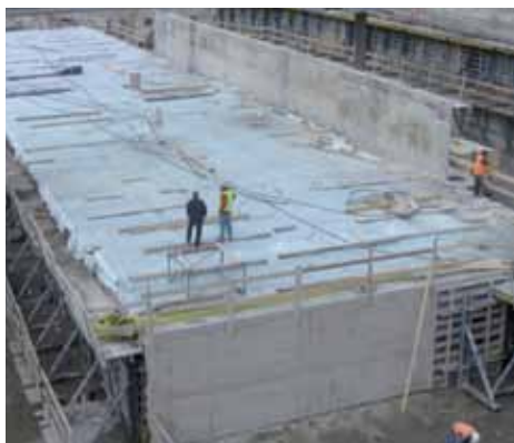
Figura 5. Alcuni esempi per una corretta procedura di maturazione delle strutture: irrorazione con acqua, utilizzo di agenti di curing, protezione con teli.
