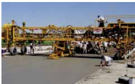
Figura 1. Fase della posa in opera di una strada in calcestruzzo drenante
