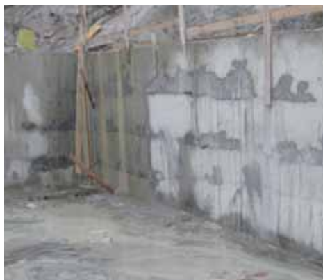
Figura 3. Pratiche "correttive" dei difetti esecutivi. Spesso i capitolati dedicano più attenzione alla scelta del prodotto da ripristino che alla corretta progettazione e specifica delle operazioni di posa in opera.
