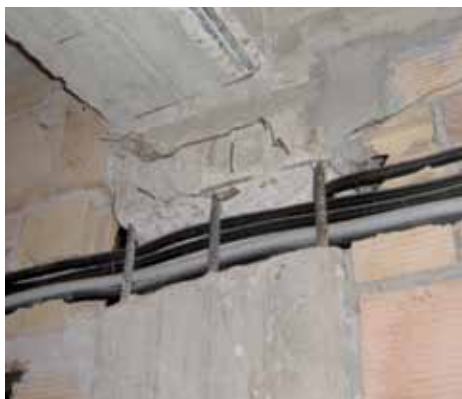
Figura 6. Edificio in zona sismica con impianto elettrico a "norma". "Aggiunta pozzolanica" non convenzionale, tipica delle operazioni di getto nel Belpaese
