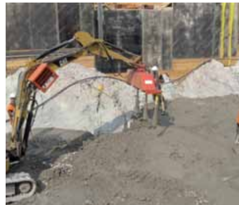
Figura 4. La vibrazione di un calcestruzzo massivo per opera idraulica: le procedure esecutive e di sicurezza richiedono un'attenta progettazione e specifica della metodologia operativa al fine di garantire qualità strutturale ed eliminare le interferenze tra le fasi lavorative.
