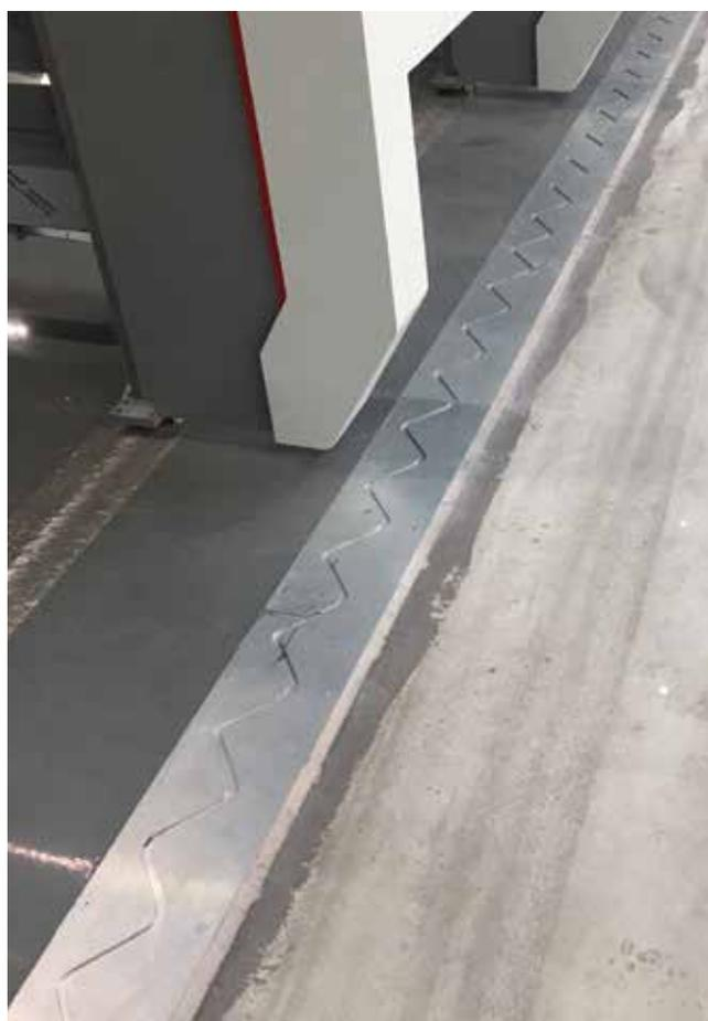
**Acciaio Inox, acciaio zincato o nero** sostituiscono l'alluminio e la superficie di passaggio è una linea sinusoidale realizzata con taglio laser. Il sistema offre così grande resistenza meccanica (nonché chimica nel caso dell'acciaio Inox) e garanzia di un transito senza scosse anche a velocità relativamente elevate.
