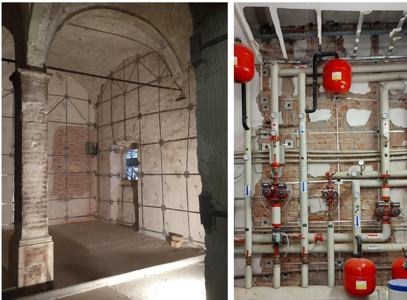
FIGURA 10: IL SISTEMA CAM® EFFICACEMENTE ADOTTATO PUR IN PRESENZA DI VINCOLI ARCHITETTONICI O IMPIANTISTICI
