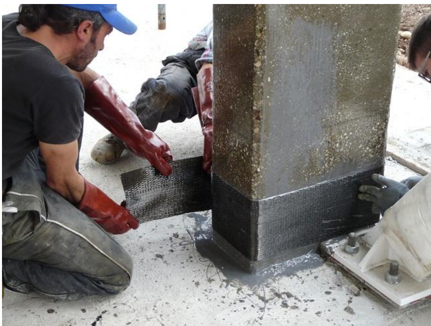
Intervento di fasciatura alla base di un pilastro (sx) e pilastro fasciato all'interno di un capannone (sx) - Sismocell
