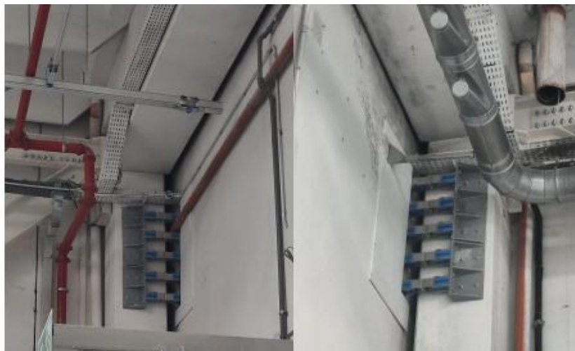
Installazione Sismobox per mitigare l'effetto di martellamento in un giunto strutturale di un capannone – Sismocell
