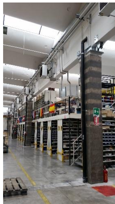
Intervento di fasciatura alla base di un pilastro (sx) e pilastro fasciato all'interno di un capannone (sx) - Sismocell
