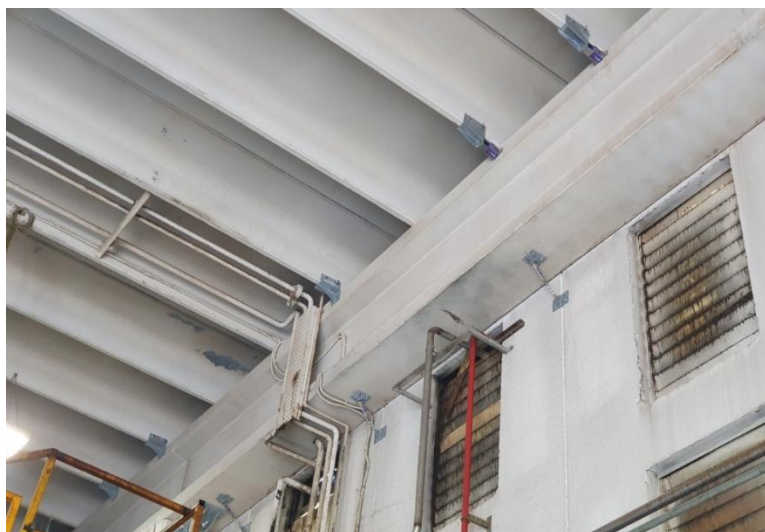
Collegamenti con dispositivi SismoShock dei pannelli di tamponamento e dei tegoli - Sismocell
