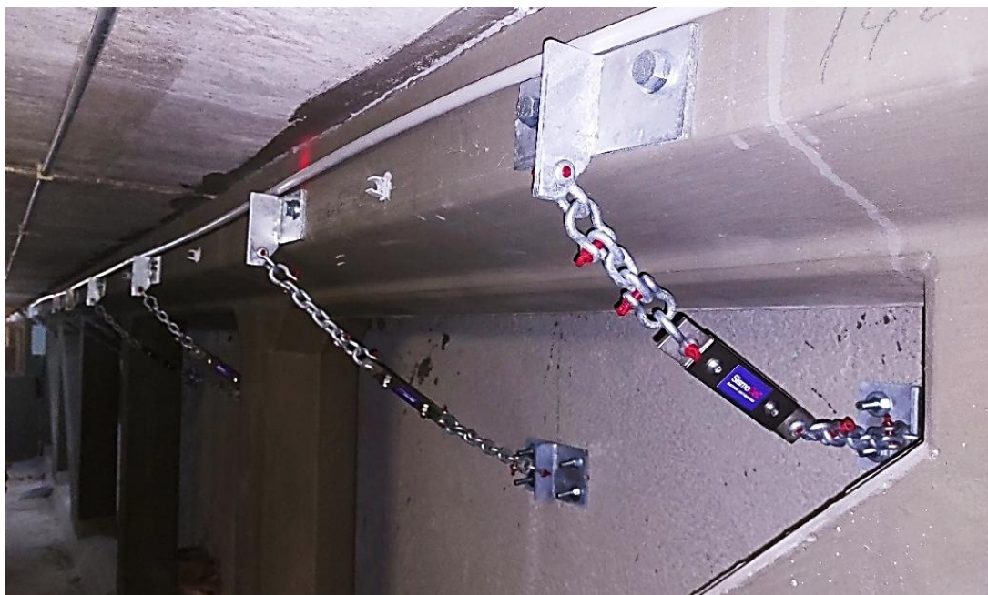
Installazione dispositivi SismoShock con elementi metallici @Sismocell
