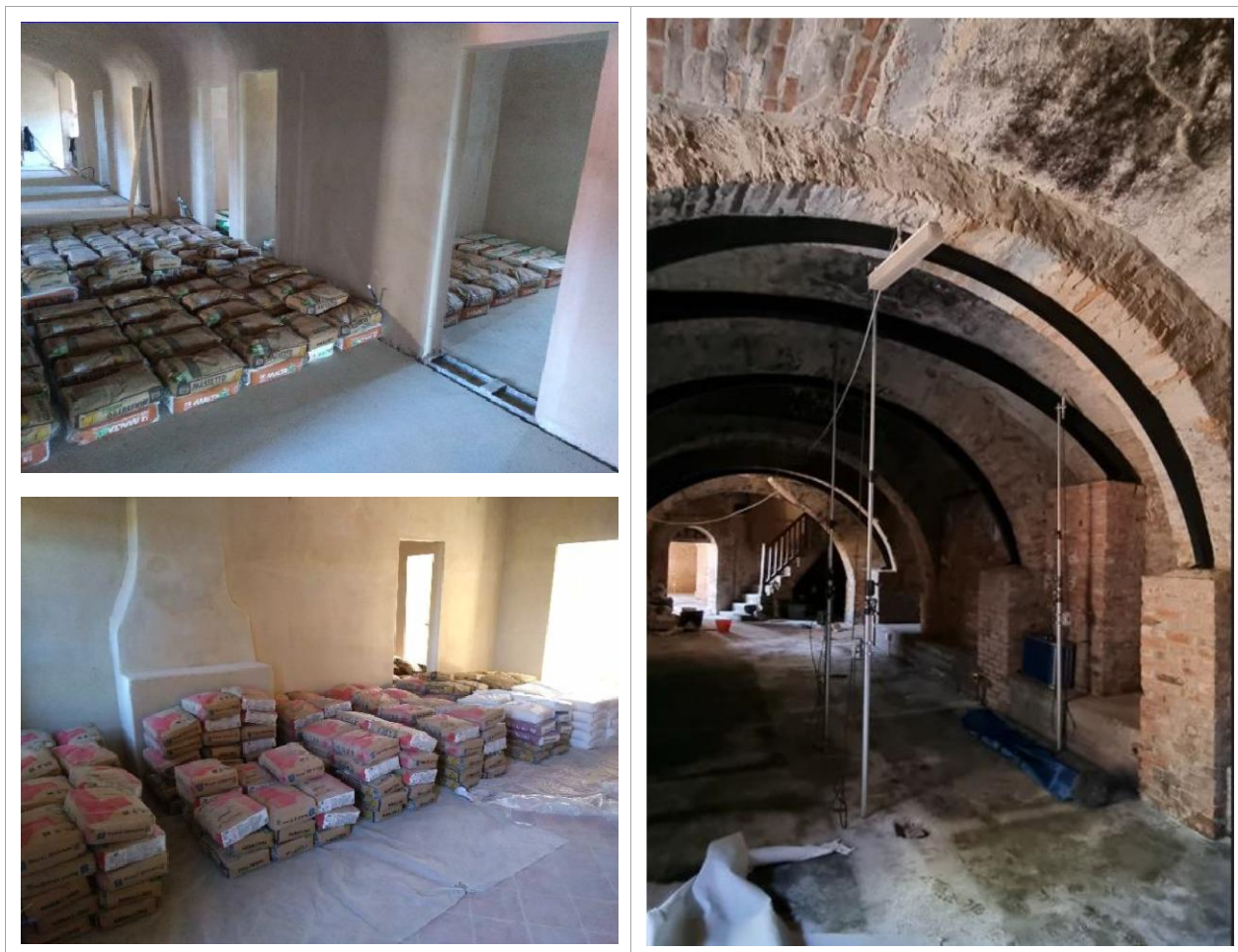
Figura 26 – Prova di carico finale.
