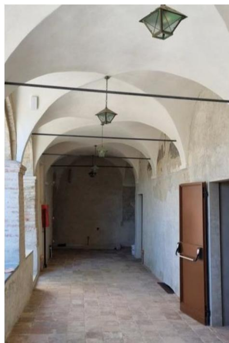
Figura 16 – Contenimento delle spinte delle volte con inserimento di tiranti metallici.
