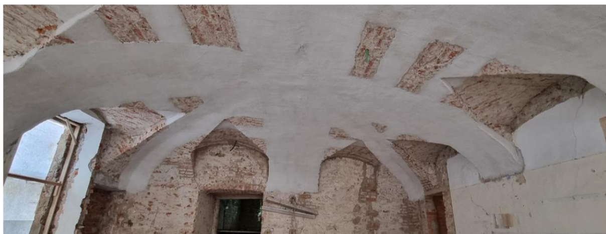
Figura 20 – Rinforzo volte in muratura mediante fibre in matrice di malta (FRCM). Vista intradosso.
