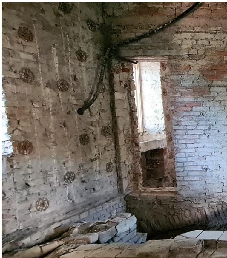
Figura 17 – Incremento della capacità portante delle murature mediante iniezioni di malta di calce e inserimento di diatoni per collegare i paramenti esterni della muratura “a sacco”.
