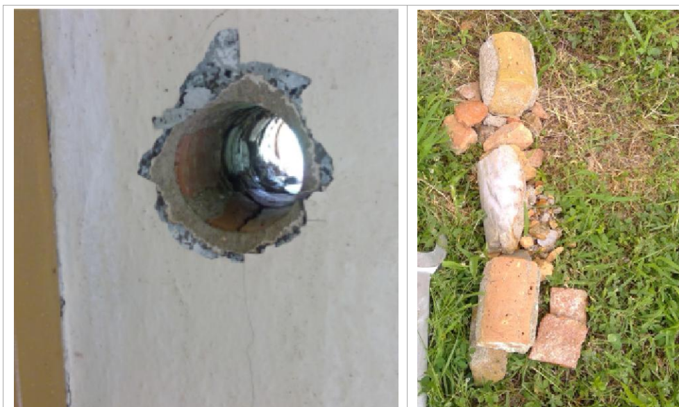
Muratura a sacco – Spessore totale 60 cm . Stratigrafia:
