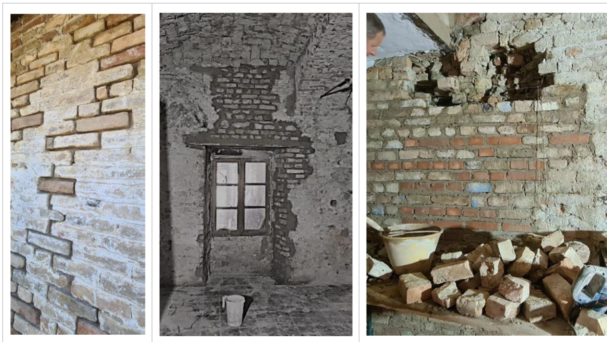
Figura 21 – Riparazione murature con tecnica «cuci e scuci».
