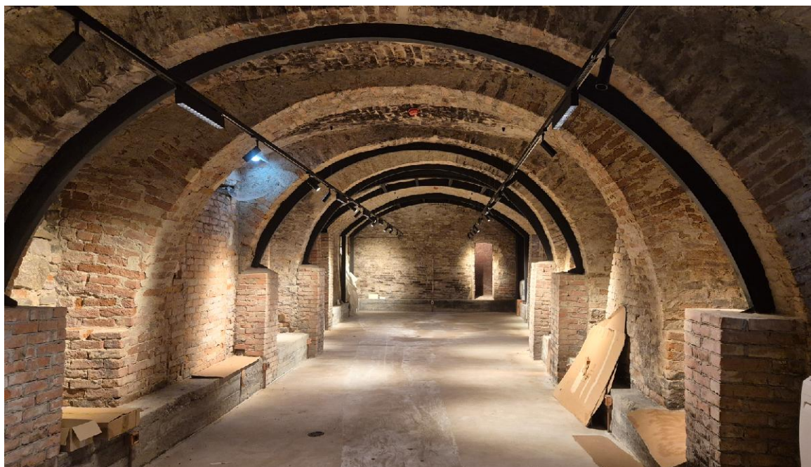
Figura 15 – Archi di contrasto al piano seminterrato
