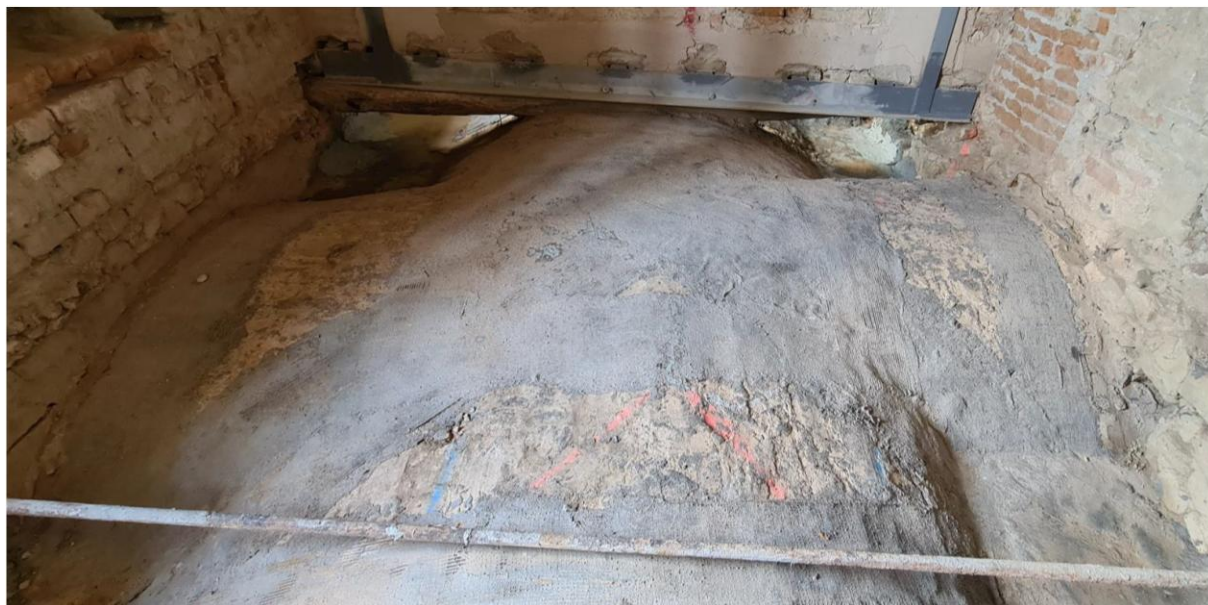
Figura 19 – Rinforzo volte in muratura mediante fibre in matrice di malta (FRCM). Vista estradosso.
