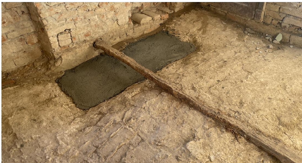
Figura 10 – Catene inefficaci ad estradosso volte
