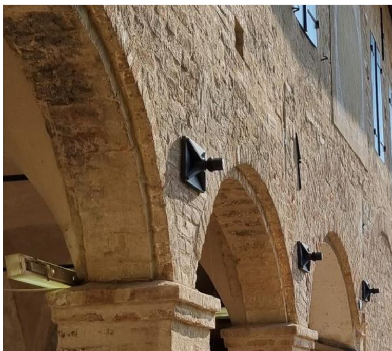
Figura 16 – Contenimento delle spinte delle volte con inserimento di tiranti metallici.
