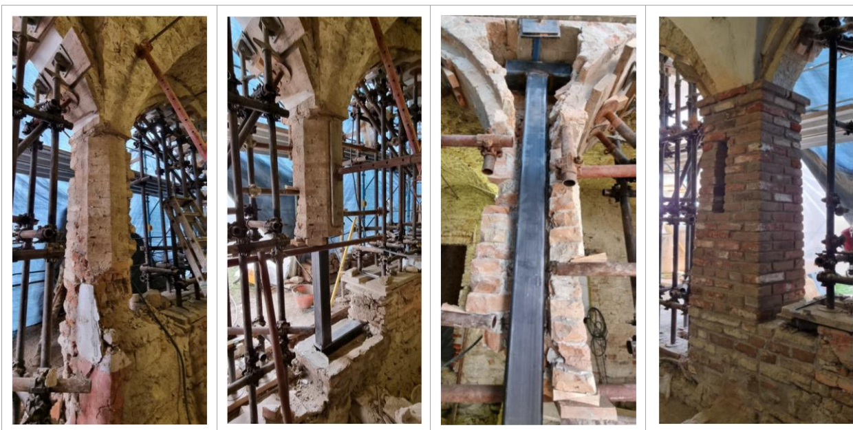
Figura 22 – Recupero murature con tecnica «cuci e scuci» e inserimento elementi metallici.
