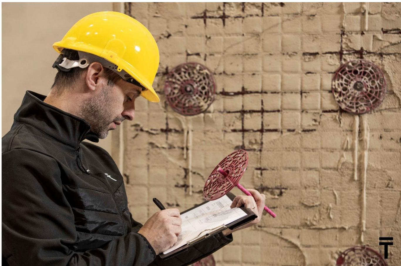
**Didascalia:** Il sistema CRM RESTAURO abbinato al sistema di connessione ARMIS ALL-IN-ONE è stato testato sperimentalmente su varia scala in collaborazione con l'Università Degli Studi di Trento, mostrando elevati incrementi di resistenza e di capacità di spostamento senza comportare incrementi di rigidità nei confronti delle azioni orizzontali.
