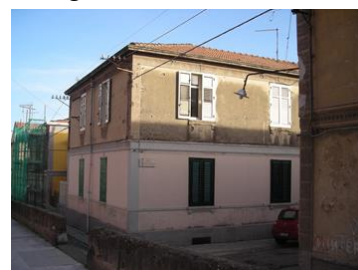
Fig.7. Edilizia popolare in muratura armata. Via Piemonte, Messina. 1921
