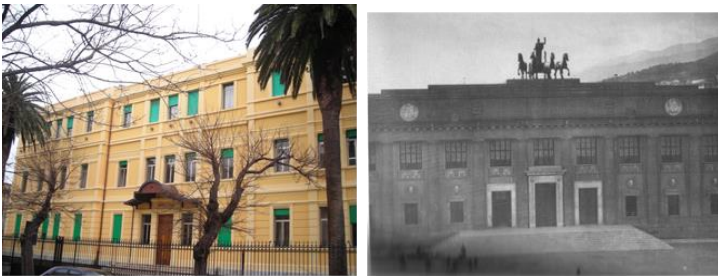
Fig.18. Edifici con ossatura in ferro esistenti: palazzo del Genio Civile e palazzo del Tribunale
