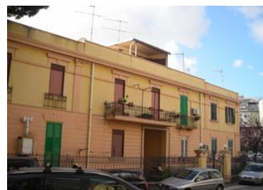
Fig.12. Isolato 377, via di Circonvallazione, case economiche in pareti in c.a. alleggerite, 1915. Planimetria originale; edificio appena ultimato; edificio oggi.
