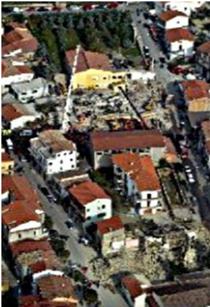
Fig.20. La scuola crollata a S.Giuliano di Puglia
