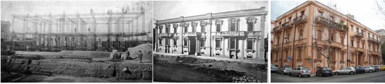
Fig. 17. Isolato 98 – angolo tra via S. Cecilia e via Centonze, ossatura in ferro, 1914-17
