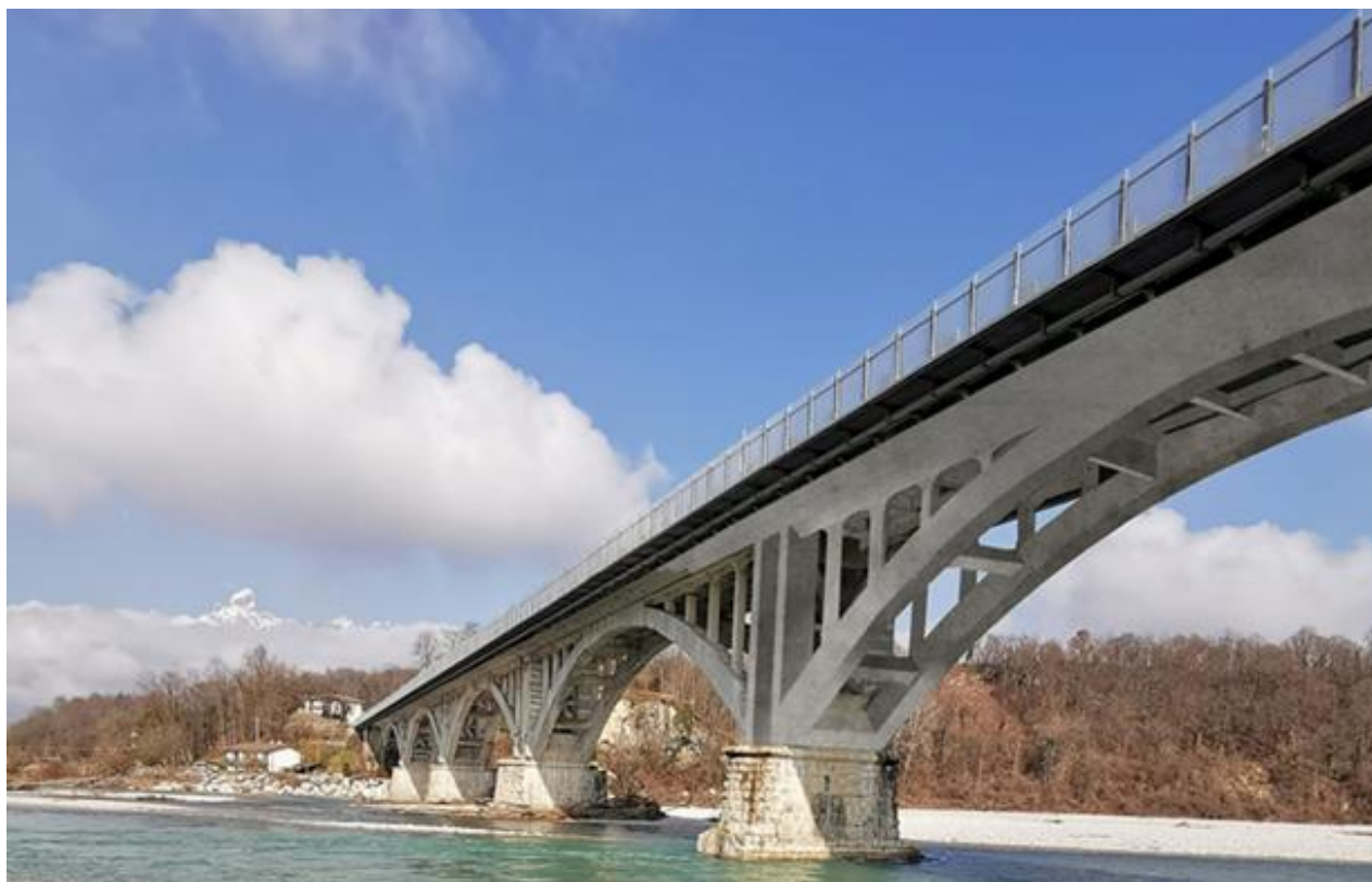
Fig. 1 Il Ponte San Felice si trova in provincia di Belluno e collega i comuni di Borgo Valbelluna e Sedico. La struttura, inaugurata nel 1930, è composta da 8 campate ad arco delle dimensioni cadauna di circa 38m x 8m per una lunghezza totale di 302m; l'altezza varia dai 9 ai 13m.
