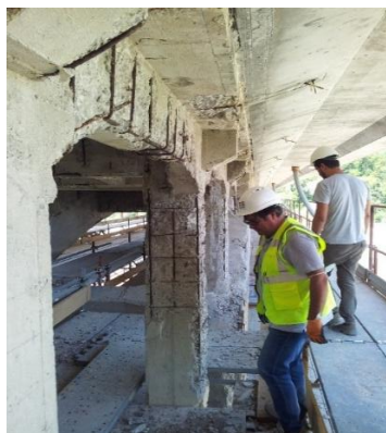
Figg.4, 5 e 6 Asportazione del calcestruzzo ammalorato e successiva passivazione dei ferri d'armatura
