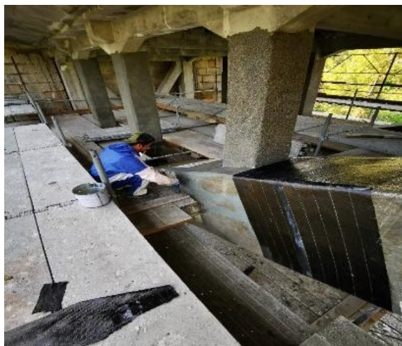
Figg. 7 e 8 dettagli del sistema FRP BETONTEX applicato in situ
