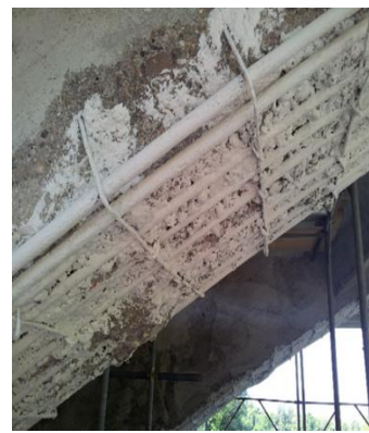
Figg.4, 5 e 6 Asportazione del calcestruzzo ammalorato e successiva passivazione dei ferri d'armatura
