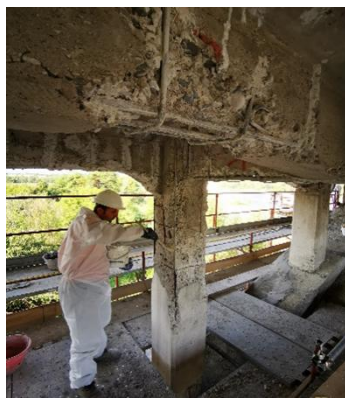
Figg.4, 5 e 6 Asportazione del calcestruzzo ammalorato e successiva passivazione dei ferri d'armatura
