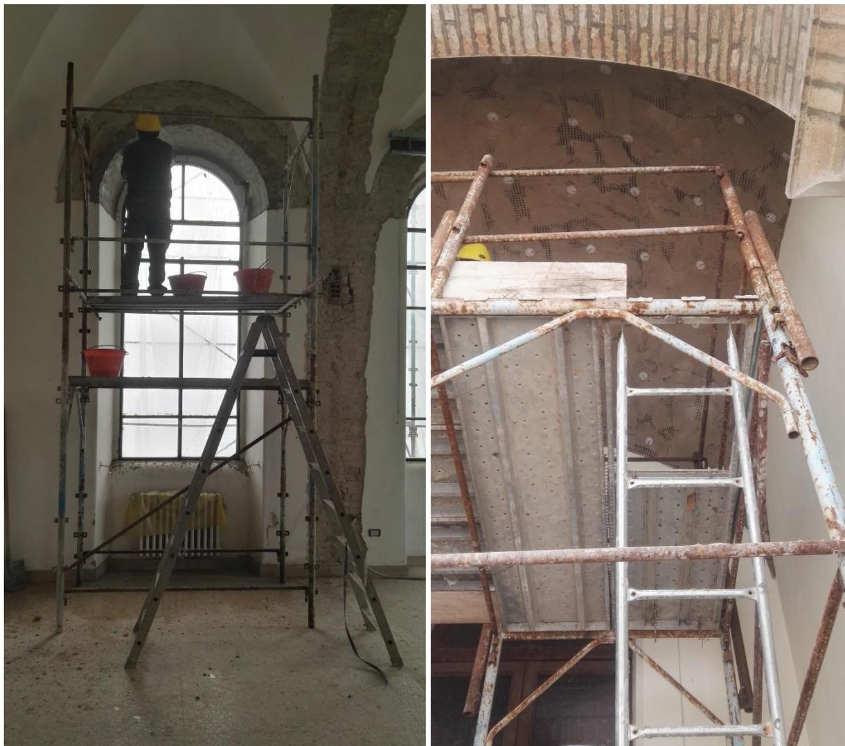
**Figura 16 e Figura 17: consolidamento degli archi e delle volte a crociera.**
