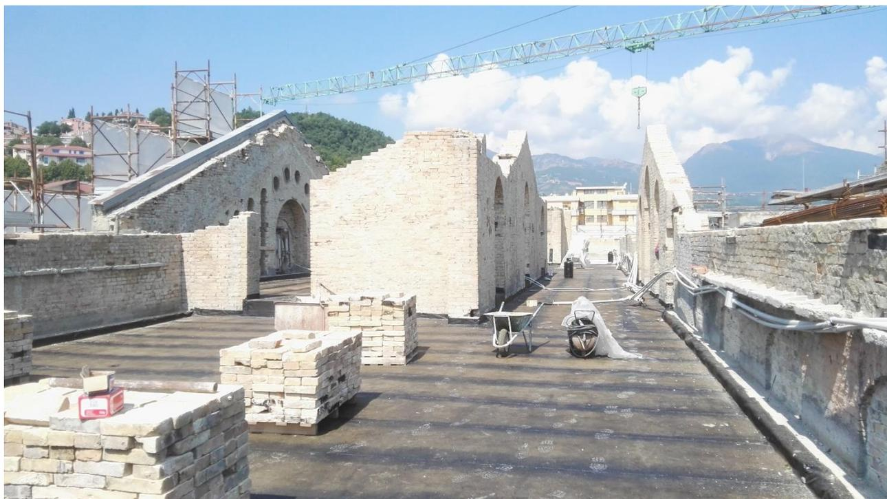
**Figura 15: rimozione della copertura esistente.**
