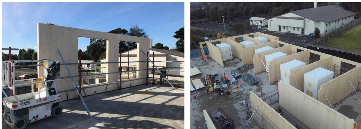
Figura 7: primo pannello installato in data 21/06/2018 e vista con bagni prefabbricati posizionati
