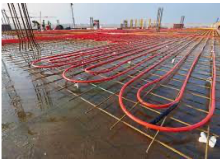
Fig. 7 - Thermally Activated Building Structures (TABS) - REHAU sistemi radianti che sfruttano l'inerzia termica della struttura edilizia.
