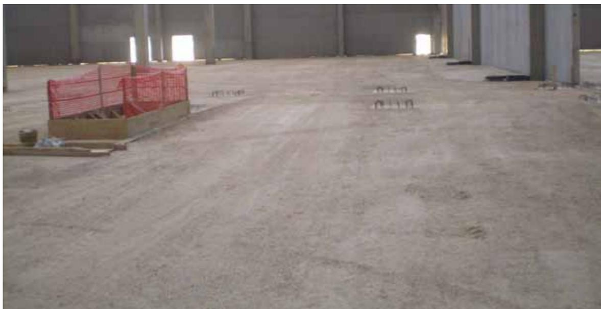
Roma, cantiere CEDIGROS: sottofondo cementato realizzato in relazione alla difformità dei moduli di Winkler rilevati dalle prove di carico. Con il Prof Ing. Napoleoni, geotecnico si è deciso di utilizzare un misto cava cementato per uno spessore di 30 cm.
