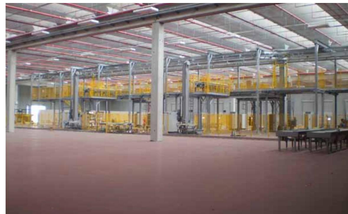
Roma, cantiere CEDIGROS: posizionamento del sistema di trasporto computerizzato Swiss Log, per il quale occorre realizzare una fondazione superficiale transitabile dai muletti, su un sottofondo assai rigido e scarsamente deformabile.
