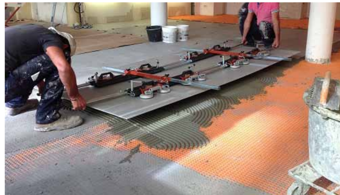
Per la posa dei grandi formati è particolarmente indicato l’impiego di sistemi collaudati di separazione tra manto ceramico e sottofondo.
