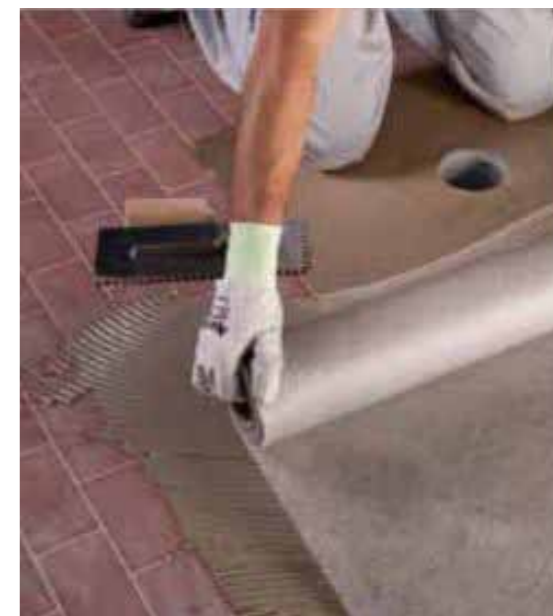
Impermeabilizzazione su pavimento esistente
