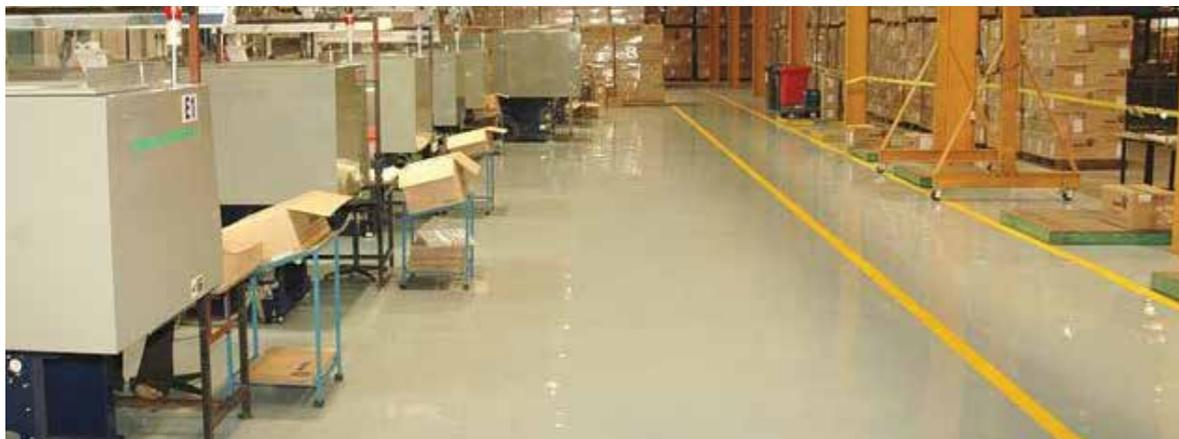
Flowcrete nella sua ampia gamma di formulati sintetici resinosi ha messo a punto un sistema **FLOWCHEM** che resiste agli acidi concentrati, alcali, solventi estremamente aggressivi idonei a qualsiasi ambienti trasformazione chimica, nonché passerelle metalliche, strutture e rivestimenti serbatoi, sia per le pavimentazioni che pareti che devono essere protetti con rivestimenti ad elevate resistenze chimiche.
