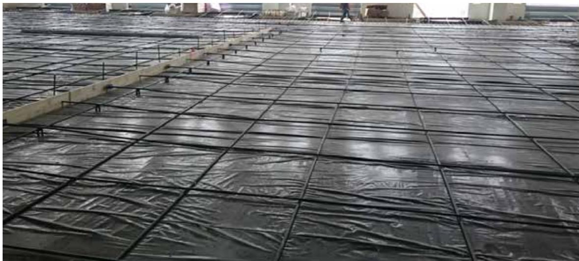
Sono 40.000 i mq di pavimentazione in via di realizzazione presso il cantiere di Pievevestina (FC), dove la UNIECO sta realizzando un nuovo centro logistico-industriale. Il Floortek Post Tension Team, grazie alla scelta della committenza di realizzare una pavimentazione innovativa e non tradizionale in calcestruzzo, si sta occupando della progettazione e della messa in opera di 30.000 mq di pavimentazione postesa.
