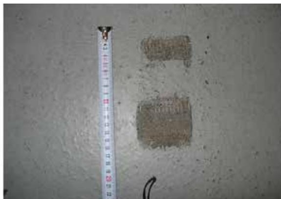
Figura 1 - Danneggiamento dovuto all'effetto di surriscaldamento indotto dalle ruote motrici dei muletti.
