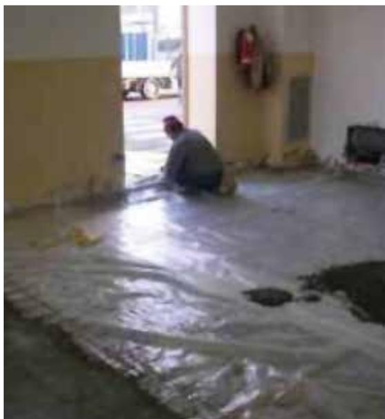
Figura 4.2 - Realizzazione di massetto desolidarizzato su foglio di polietilene
