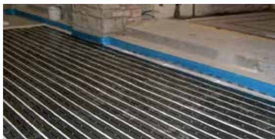
del fluido termovettore è in PE-Xc con barriera antiossigeno, del diametro di 14 mm e dello spessore di 2 mm, in polietilene reticolato ad alta densità per via elettrofisica, prodotto in conformità alla norma DIN EN 15875 e 4726, a garanzia di qualità e durata nel tempo.
