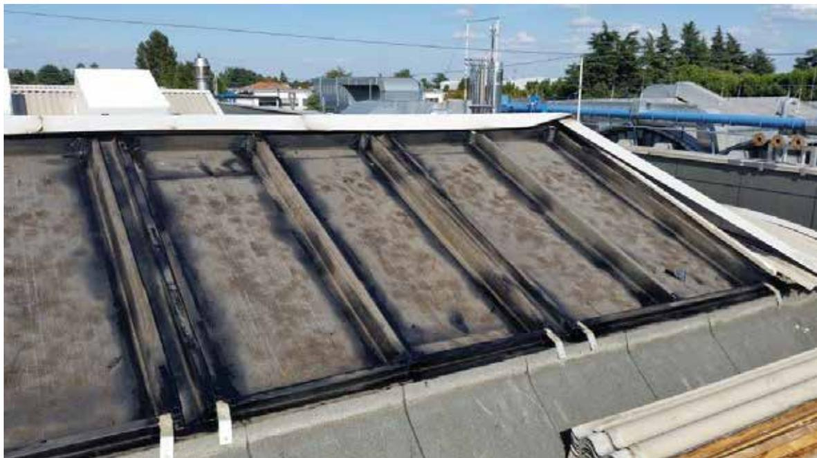
*La copertura dopo rimozione elementi vetusti e di discontinuità*
