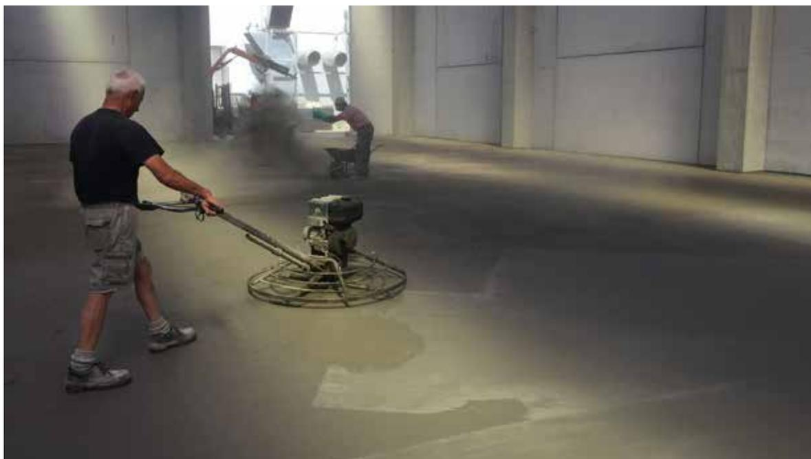
Figura 2 - Spargizione della miscela di spolvero e finitura ad elicottero
