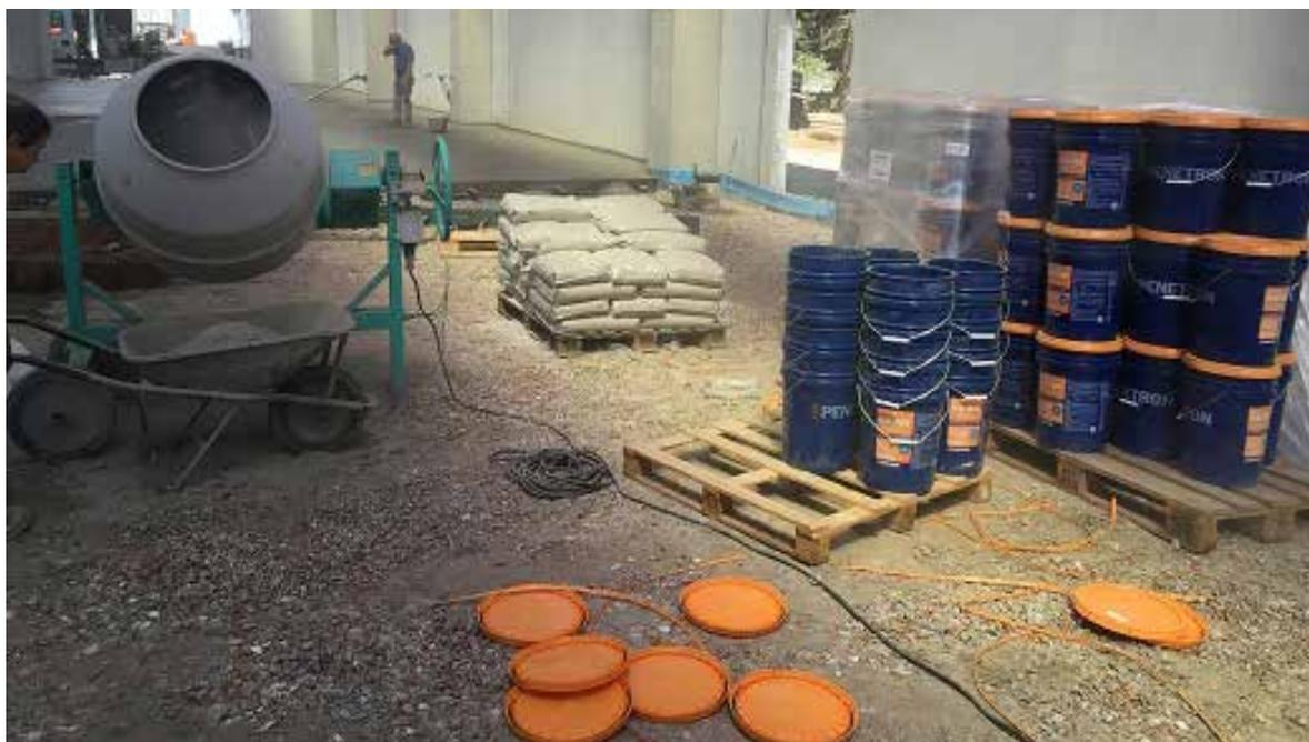
Figura 1 - Miscelazione a secco del PENETRON STANDARD con quarzo puro
