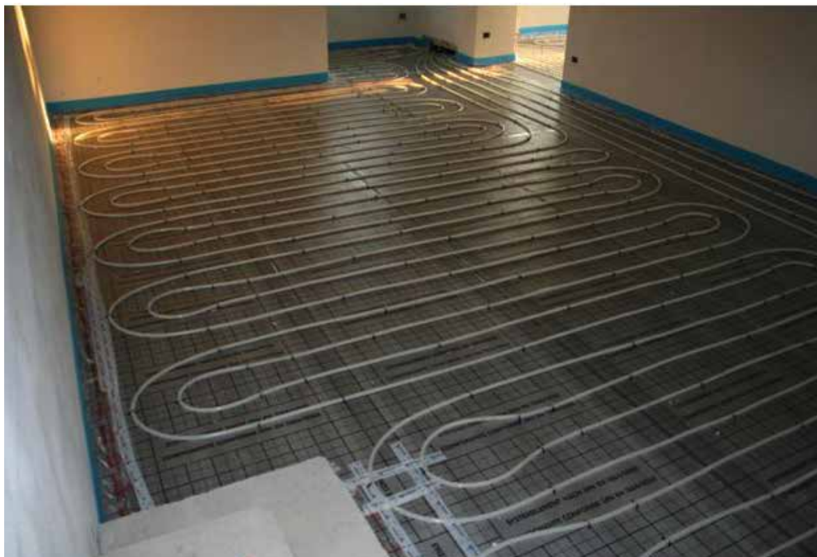
Figura 1 - Sistema radiante a pavimento. (Fonte: Tiemme)
