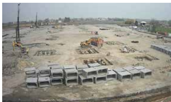
Realizzazione pali di fondazione
