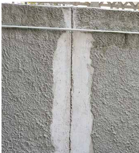
Fessurazione prima e dopo sigillatura con BI-Flex VOLTECO
