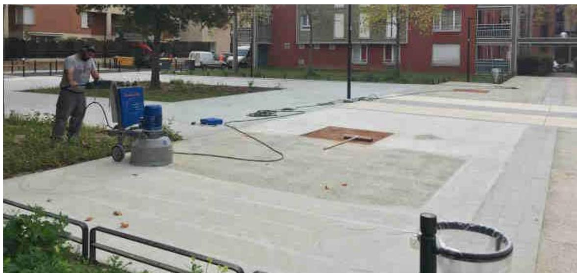
La bocciardatura è un trattamento realizzato su superfici in calcestruzzo, pietra naturale, marmo, granito ed asfalto attraverso l'impiego di LEVIGATRICI PLANETARIE e BOCCIARDE con punte in carburo di tungsteno, che grazie all'effetto della rotazione delle attrezzature permettono di ottenere una superficie ruvida, e pertanto di ottenere allo stesso tempo un effetto antiscivolo e di grande impatto estetico.
