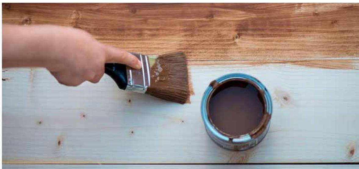
Ne esistono di molte tipologie, anche se possono essere schematicamente suddivise in tre categorie generali: a solvente, all'acqua e fotoreticolabili, meglio conosciute come "Uv". Ma le più innovative sono le bio-vernici, derivanti da biomasse.
