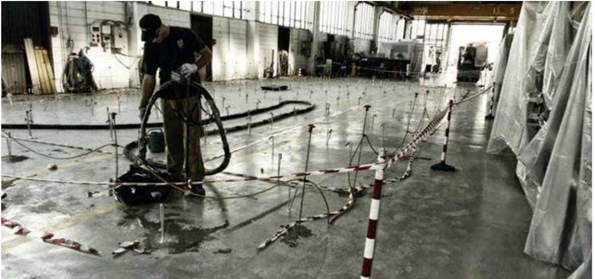
Le sollecitazioni, statiche e dinamiche, che agiscono nel tempo sulle pavimentazioni industriali e le perdite di fluidi nel terreno sono le cause principali del disturbo del terreno sottostante.
