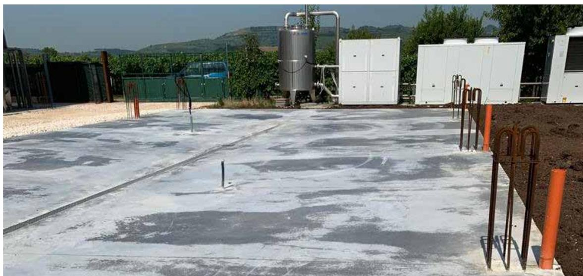
Quale è la causa delle macchie scure sui pavimenti in calcestruzzo? In seguito all'evaporazione dell'acqua d'impasto e all'innesco della fase di indurimento, la tonalità di grigio della pavimentazione varia nel tempo per raggiungere una colorazione definitiva a maturazione avvenuta.
