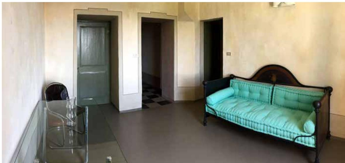
Nella ristrutturazione di una antica villa nelle colline di Acqui Terme, l'architetto Martina Tornato ha scelto i rivestimenti in resina Spaziocontinuo di Litokol per ottenere una superficie finale spatolata materica a tinta uniforme riuscendo a nascondere le sagome delle marmette a pavimento esistenti. Le lievi increspature rettilinee del pavimento in resina fanno vibrare la superficie a seconda dell'incidenza della luce. Il risultato è un mix di stile tra antico e moderno, in perfetta armonia.
