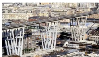
VISTA DELLE PILE A V RIPARATE
