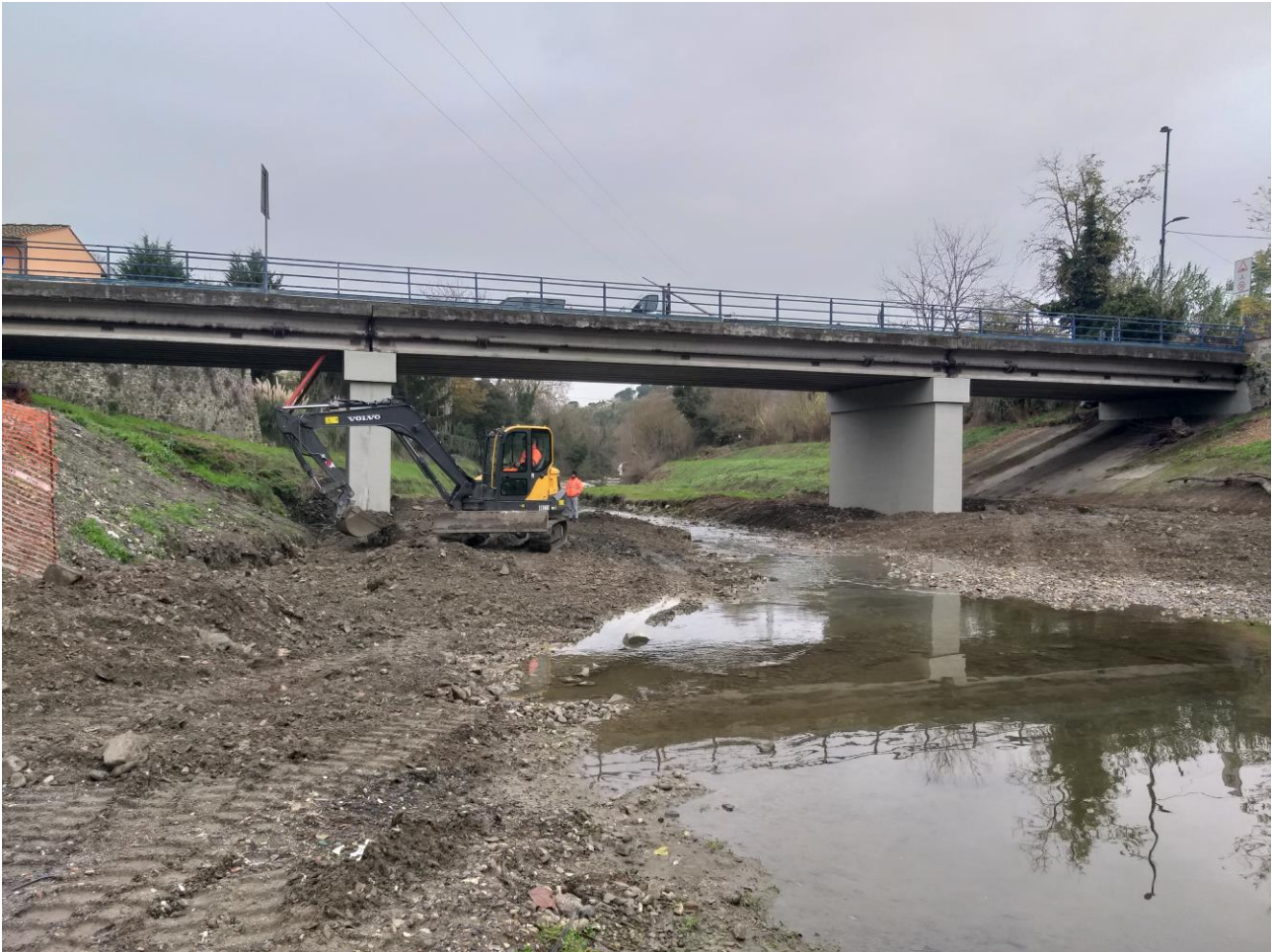
Figura 4 - Vista del Ponte della Gora a ripristino di pile e pulvini terminato.
