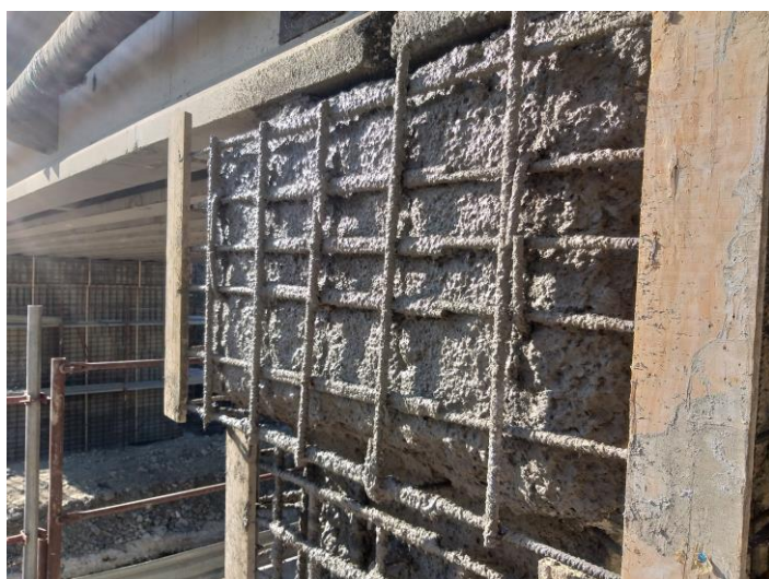
Figura 2 - Dettaglio relativo all'applicazione a spruzzo di FLUECO 80 T FIBER.
