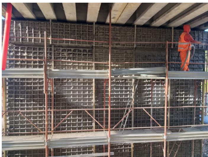
Figura 1 - Consolidamento delle pile con FLUECO 80 T FIBER.
