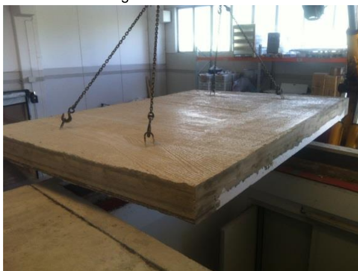
Immagine 3. Solaio Airfloor realizzato a pié d'opera e posizionato sopra la camera acustica
