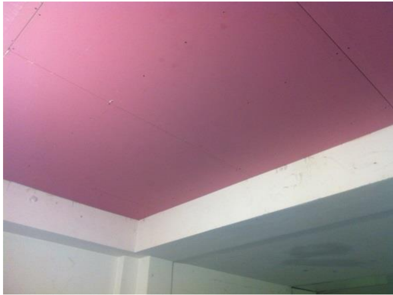
Immagine 4. Interno della camera acustica: solaio rivestito con cartongesso
