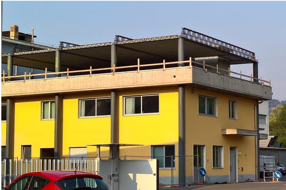
Immagine 2. Esempio di sopraelevazione realizzata con travi e pilastri NPS abbinati al solaio Airfloor™
