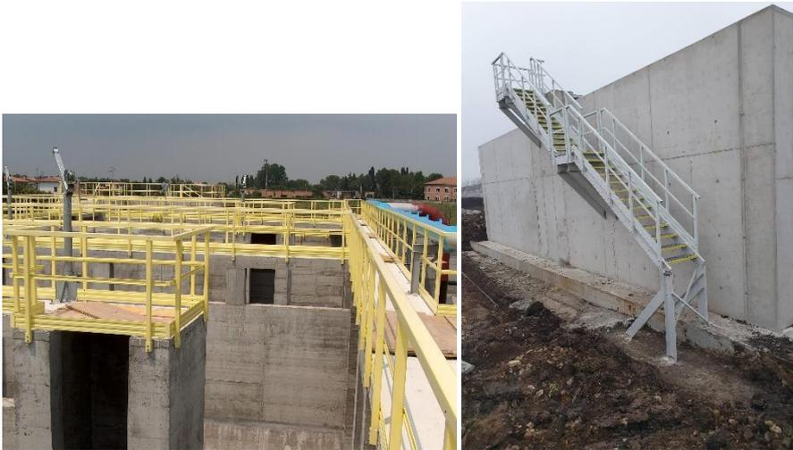
*Esempi di strutture realizzate con profili e grigliati in PRFV della M.M. Srl, nel trattamento acque*
