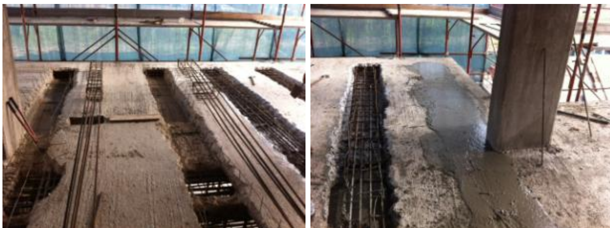
Fig11 – Intervento di rinforzo solai
