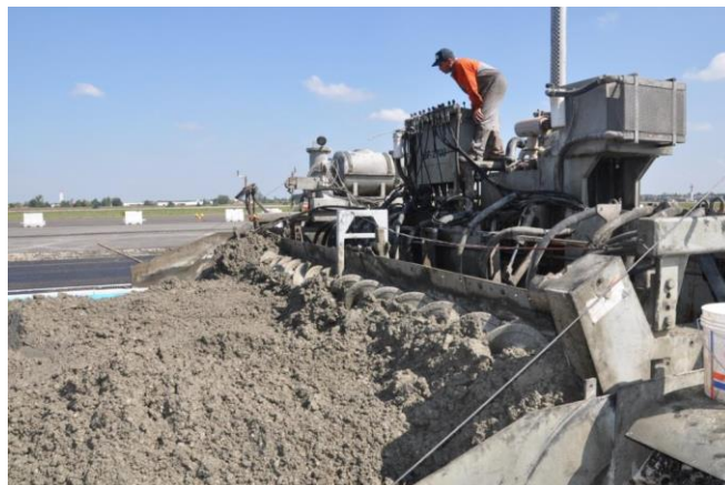
Figura 6. Le coclee distribuiscono il calcestruzzo
