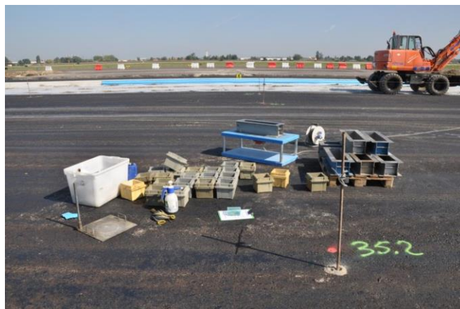
Figura 10. Controlli di accettazione sul calcestruzzo durante la messa in opera.
