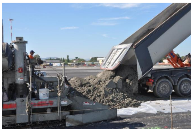
Figura 5. Scarico del calcestruzzo.
