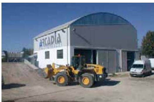
ARCADIA Calcestruzzi S.p.A. Impianto Tipo PREMIX ad INVISIBILITÀ TOTALE realizzato INTERAMENTE all'interno di un capannone industriale Produzione 120 mc./h.
