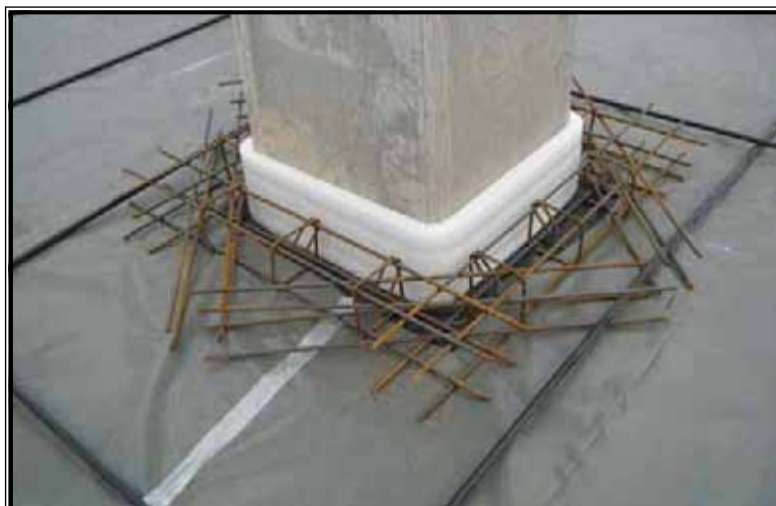
Figura 4 – Posizionamento armatura di rinforzo.
