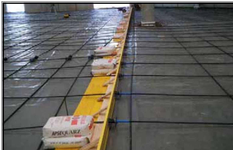
Figura 3 – Realizzazione campo di getto con trefolo passante e sistemazione degli ancoraggi.
