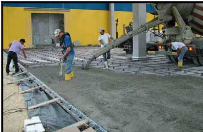
Figura 5 – Esecuzione getti con fissaggio dei trefoli.
