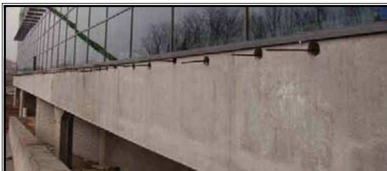
Figura 7 – Esecuzione fori passanti per il posizionamento dei trefoli con tesatura dall'esterno.
