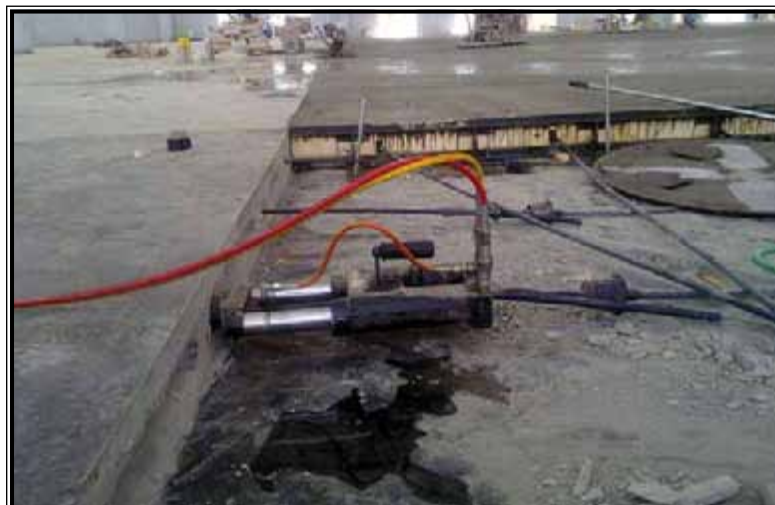
Figura 6 – Tesatura dei singoli trefoli mediante martinetto idraulico.
