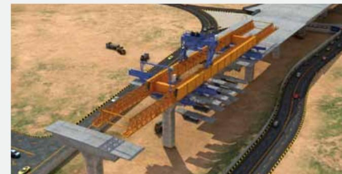
Figura 4 – Impalcato a conci - Varo "Span-By-Span"
