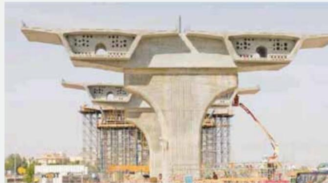
Figura 6 – Pila tipica e diaframma “testa-pila” monolitico
