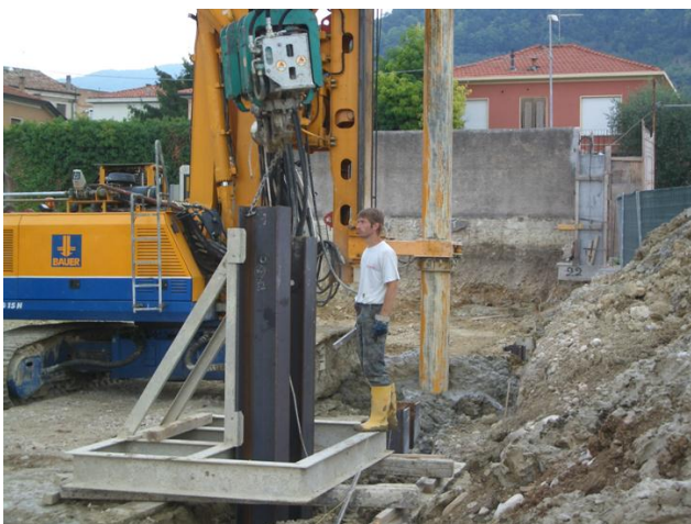
Figura 6. Infissione dell'armatura a mezzo di vibratore (Dolomiti Rocce, Vittorio Veneto)
