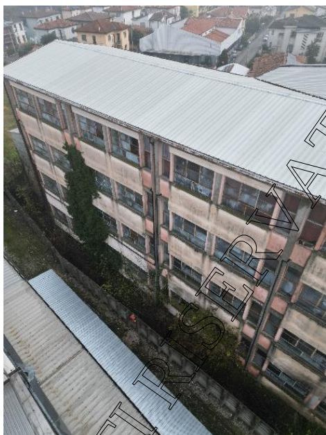
Figura 4 Vista aerea prospetto nord-ovest
