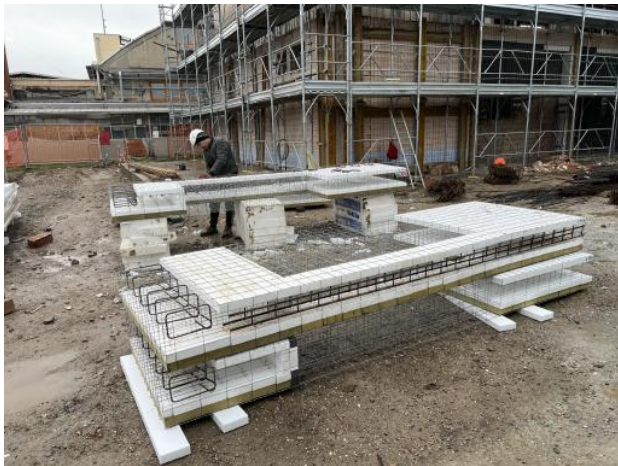
Figura 31 Inserimento a terra delle armature
