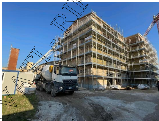
Figura 33 Fase di getto del secondo piano
