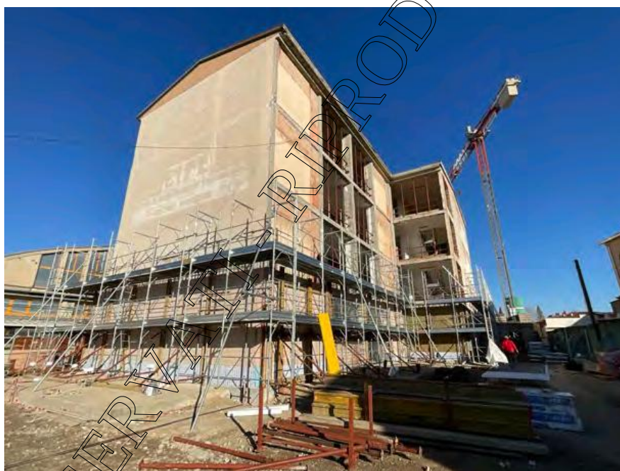
Figura 30 Posa dei moduli del piano terra
