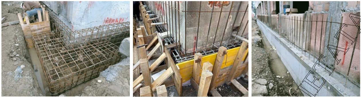
Figura 25 Foto delle fondazioni
