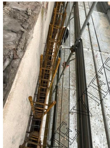
Figura 32 Armature di ripresa calate dall'alto una volta posizionato il cassero
