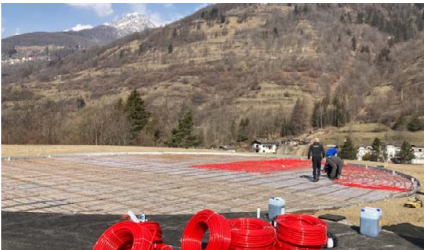
Fig. 01-6 Applicazione speciale sistema radiante REHAU – Piazzola di atterraggio elicotteri Helimast a Pontagna di Temù, Alta Val Camonica.
