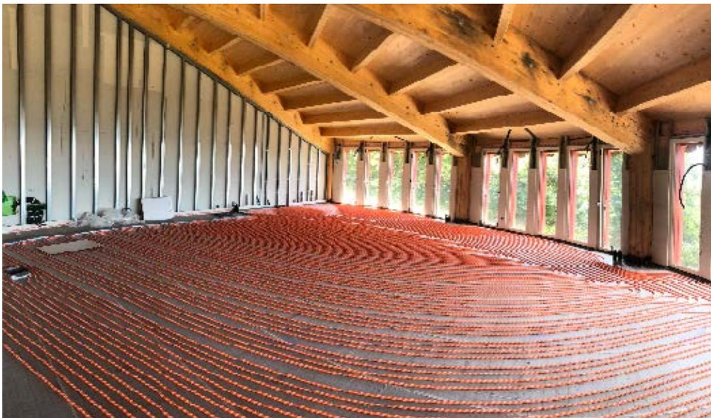
Fig. 01-5 Posa del sistema radiante RAUTHERM SPEED Silver presso il Tempio del Cielo sulla Terra, tempio buddhista tibetano più grande d'Europa, situato ad Albagnano di Bèe (VB).
