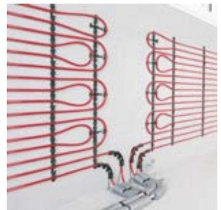
Fig. 01-4 Le soluzioni radianti a pavimento, parete e soffitto possono essere combinate per raggiungere determinati fabbisogni di riscaldamento/raffrescamento.
