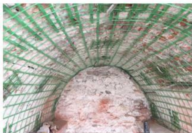
Fig.3 Alcuni dettagli della posa della rete in GFRP del sistema RI-STRUTTURA. Foto @Emilio Prete
