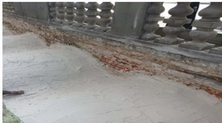
Fig.2 Fasi di preparazione del supporto e applicazione del sistema RI-STRUTTURA. Foto @Emilio Prete
