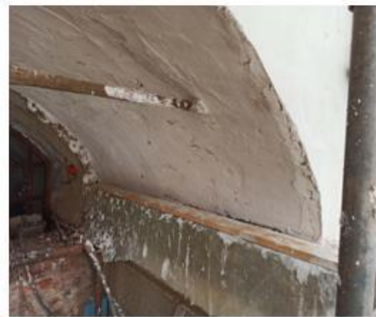
Fig.3 Alcuni dettagli della posa della rete in GFRP del sistema RI-STRUTTURA. Foto @Emilio Prete
