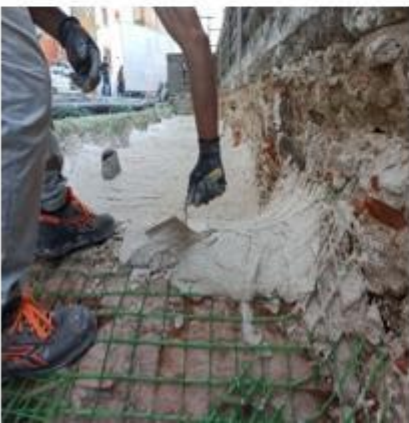
Fig.2 Fasi di preparazione del supporto e applicazione del sistema RI-STRUTTURA. Foto @Emilio Prete
