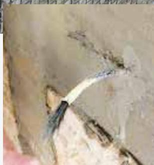
**Ancoraggi con barre inox Steel Anchorfix
