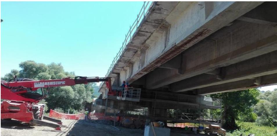
*Figura 1: esempio di degrado di un impalcato da ponte con travi in c.a.p.*
