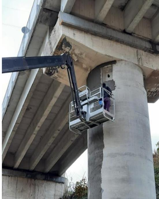
*Figura 2: Rasatura fusto pila di un ponte con Rasocem RA*
