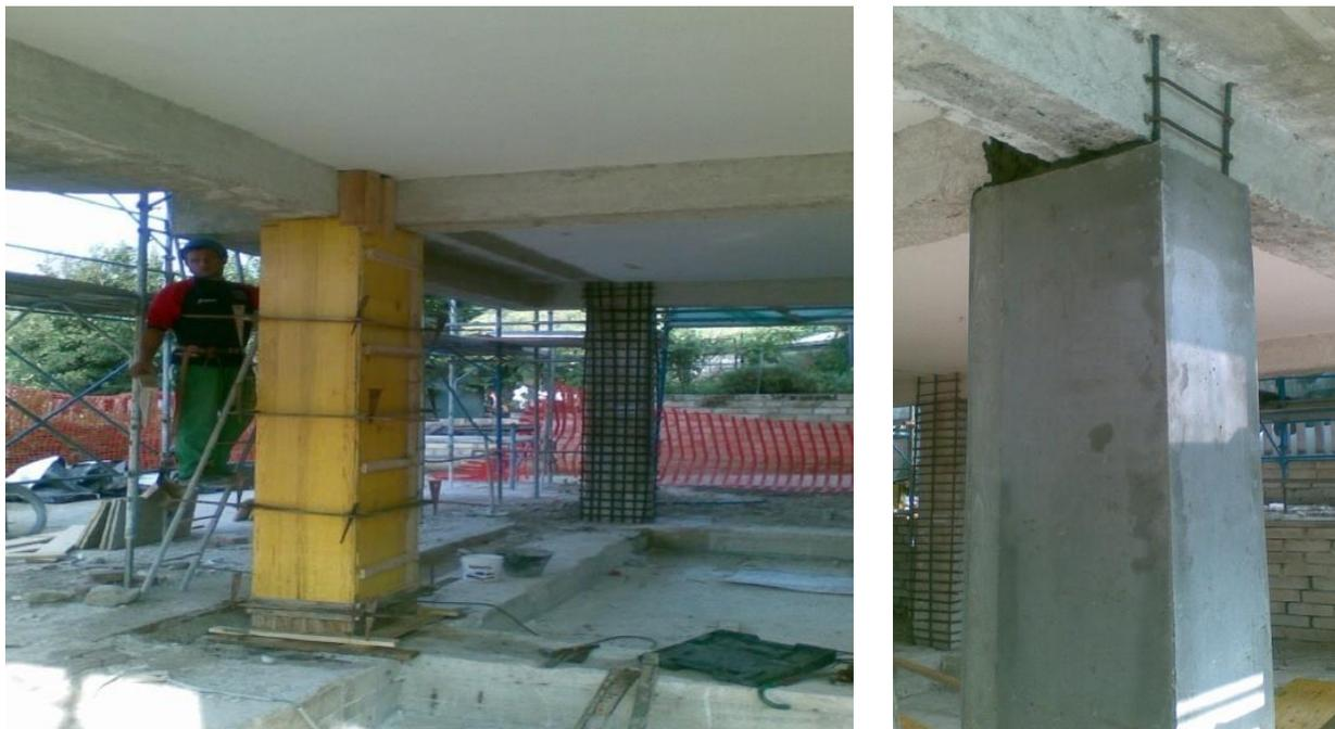
*Figura 5: incamiciatura di pilastri in c.a.*
