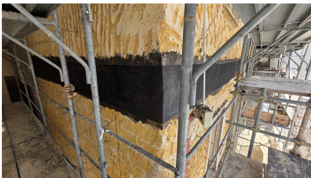
Figura 5: Fasciatura di piano con sistema FRP
