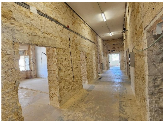
Figura 2: Vista interna corpo A oggetto di intervento
