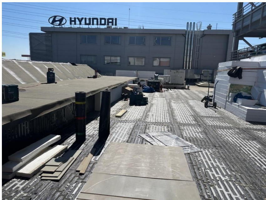
Posa dello strato di controllo del vapore FIBERFLEX STRIP
