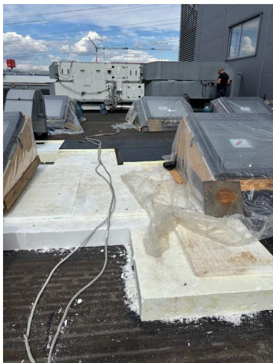
Posa del primo strato di pannelli isolanti EPS con spessore 20 cm
