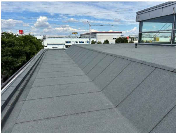
Particolare della copertura con geometrie variabili e piani inclinati
