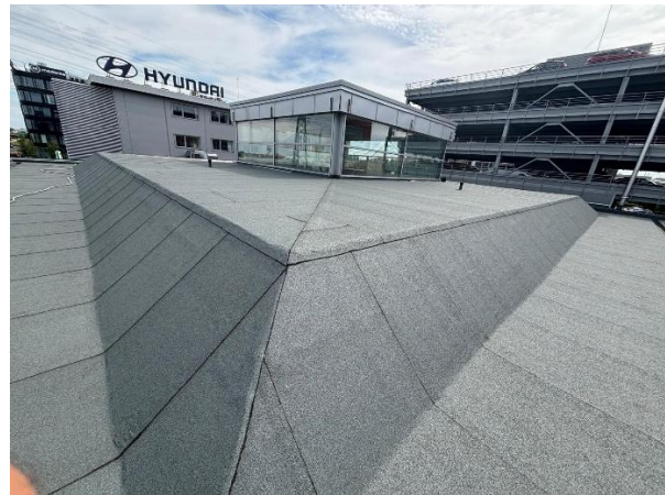
Particolare della copertura con geometrie variabili e piani inclinati
