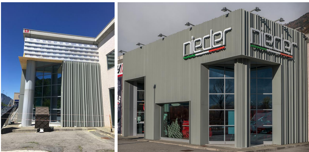
La sede della Nieder cambia volto: il rivestimento metallico personalizzato sulla facciata.
