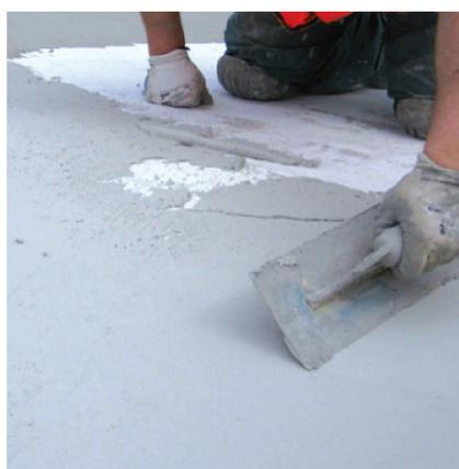
A completa asciugatura del primer l'intera superficie è stata rivestita con il rasante epossimentizio **MATERICA POOL FONDO**, applicato a spatola in due mani. Tra una mano e l'altra la superficie è stata carteggiata accuratamente per eliminare le eventuali creste o riporti di materiale. **MATERICA POOL FONDO** funge anche da mano di aggancio per l'adesione del successivo strato di finitura **MATERICA POOL SURFACE**.
